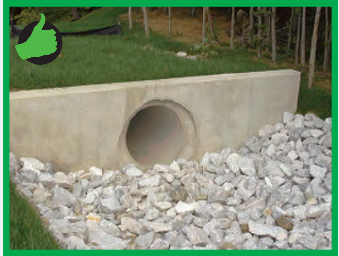
F. Riprap Ditch
