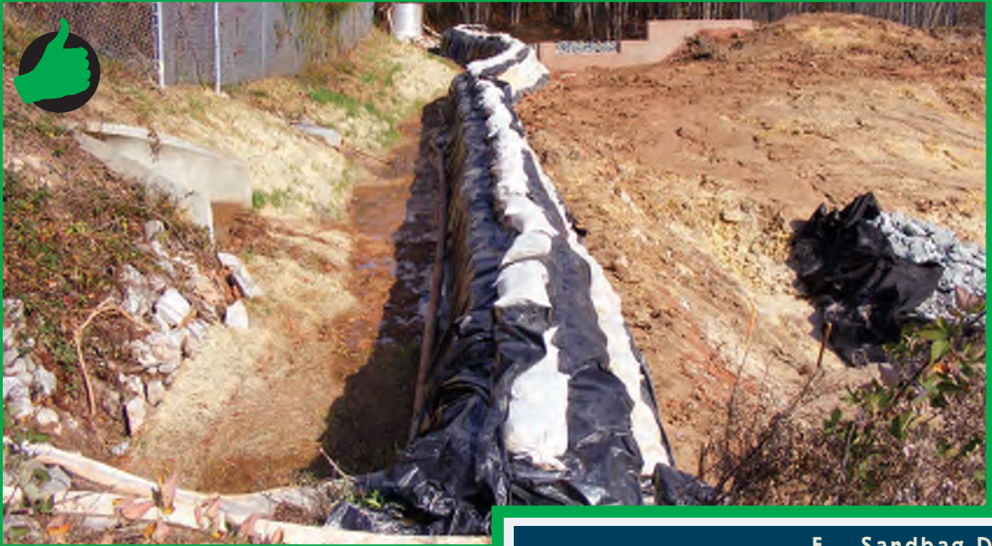
F. Sandbag Dike
