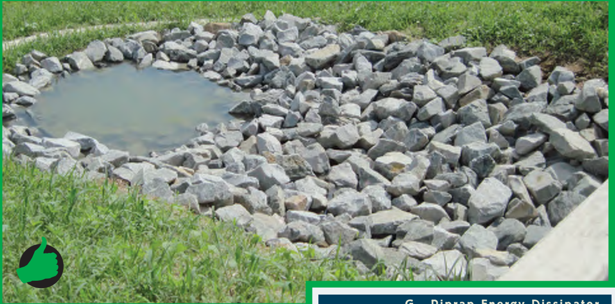
G. Riprap Energy Dissipator
