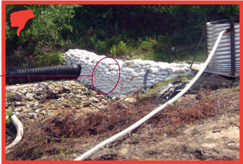
F. Sandbag Dike
